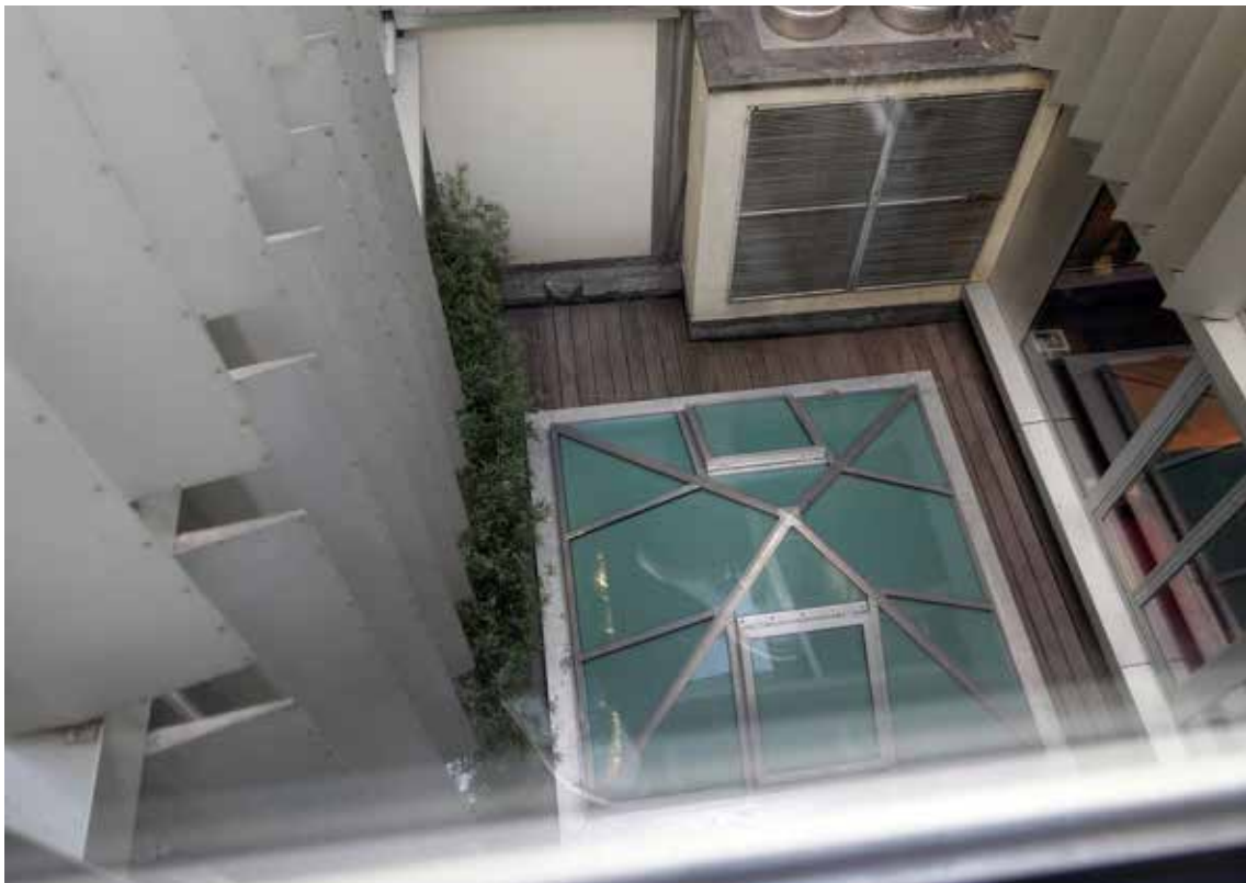
Verrière au fond d'une cours installée en 2006 (photo Y. Delemontey, 2020).
