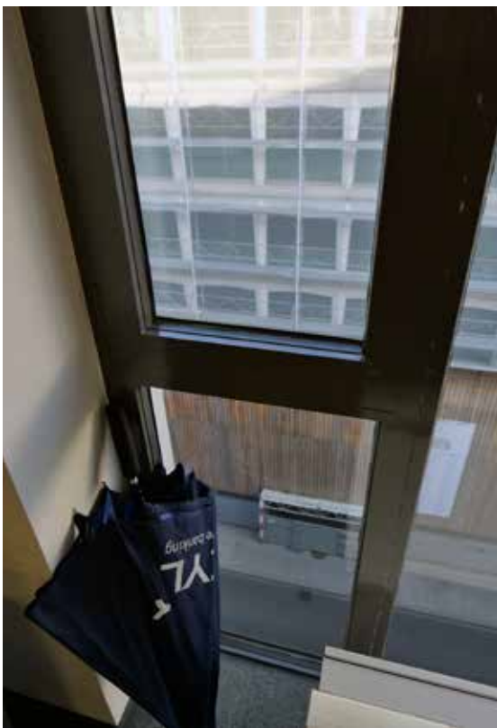
Détail des châssis vitrés en aluminium eloxé côté rue du Rhône (photos Y. Delemontey, 2020).
