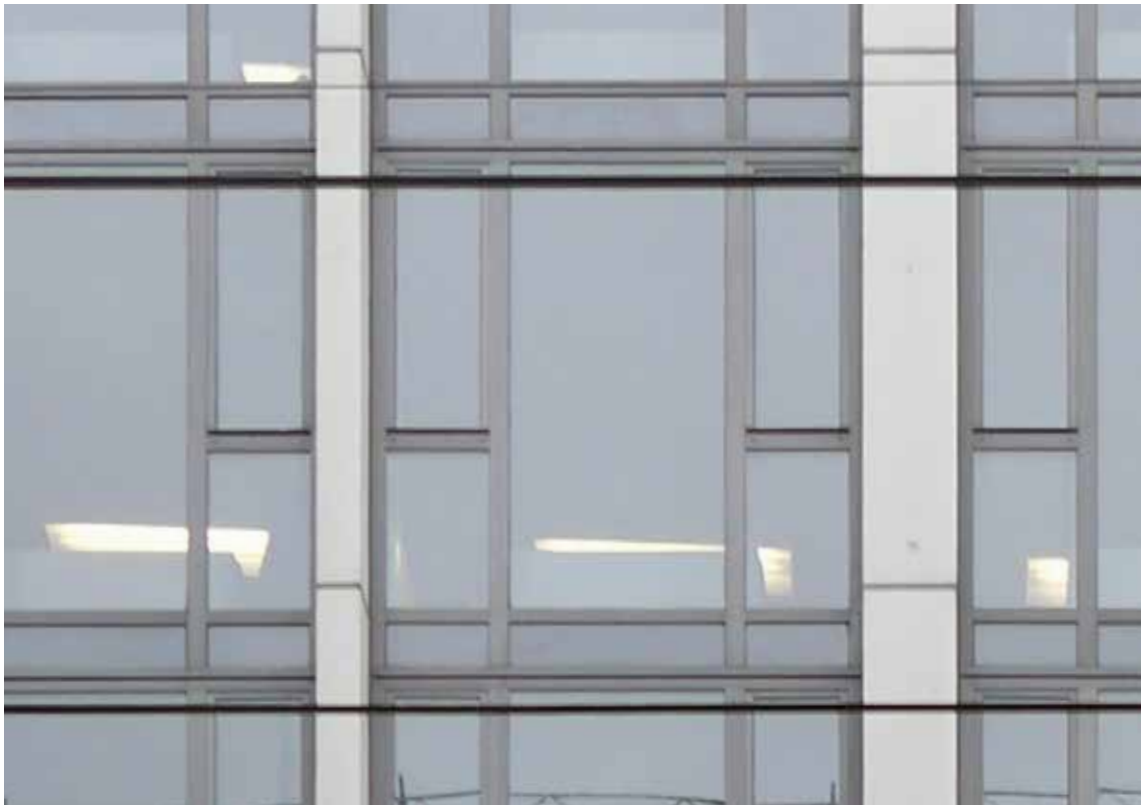
Détail de la façade rue du Rhône (photo Y. Delemontey, 2020).
