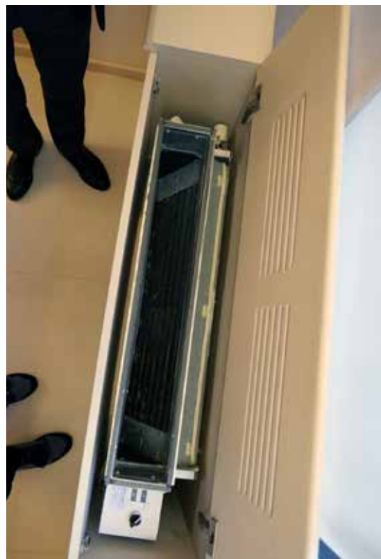
Ventilo-convecteurs d'origine encastrés et dissimulés sous les fenêtres côté rue du Rhône (photos Y. Delemontey, 2020).
