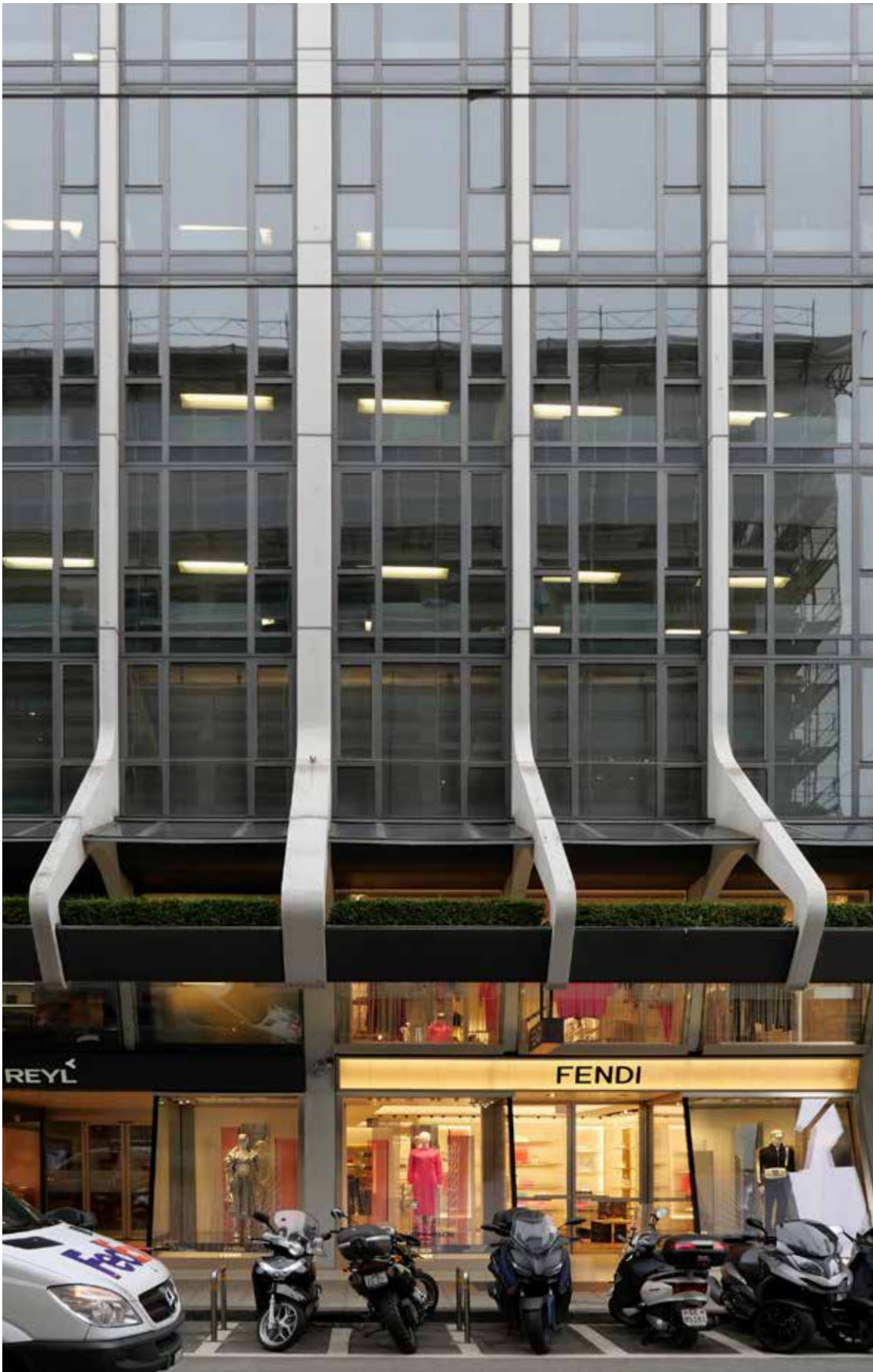
Fragment de la façade sur la rue du Rhône (photo Y. Delemontey, 2020).
