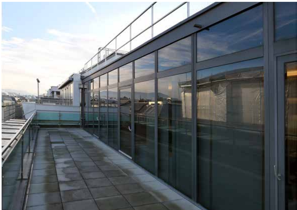
Façade vitrée en attique (photo Y. Delemontey, 2020).
