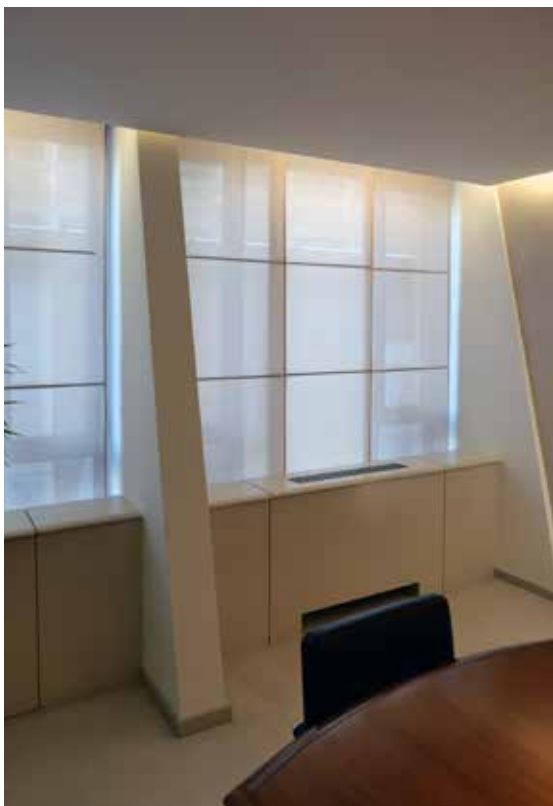
Ventilo-convecteurs d'origine encastrés et dissimulés sous les fenêtres côté rue du Rhône (photos Y. Delemontey, 2020).
