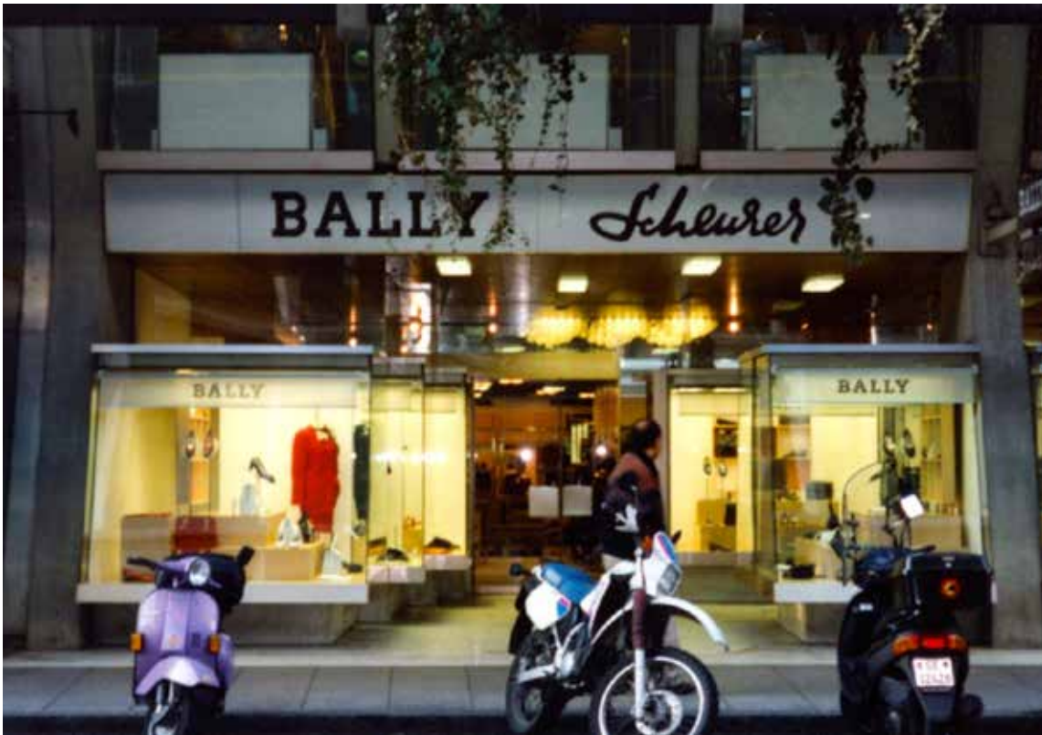
Disposition en redent des vitrines amenant progressivement le chaland vers l'entrée de la boutique, 1998 (photo C. Bischoff).
