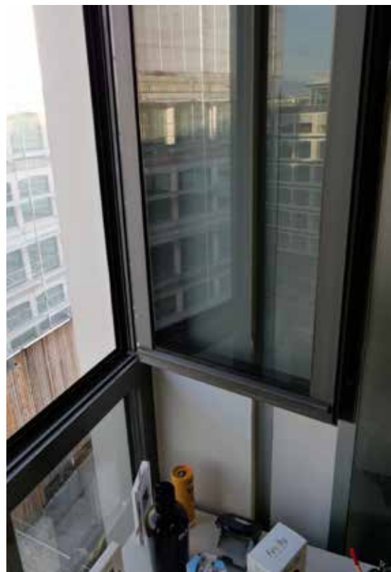
Détail des châssis vitrés en aluminium eloxé côté rue du Rhône (photos Y. Delemontey, 2020).
