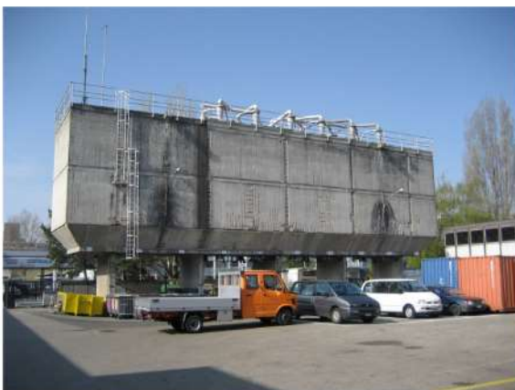
Les silos avant rénovation
